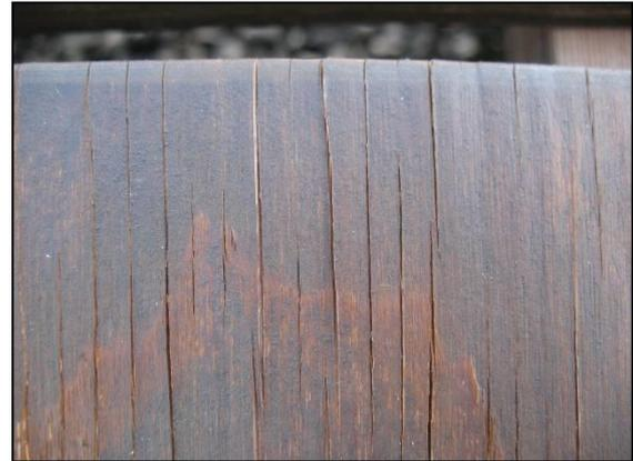
Fig. 2.3 : Fissuration
