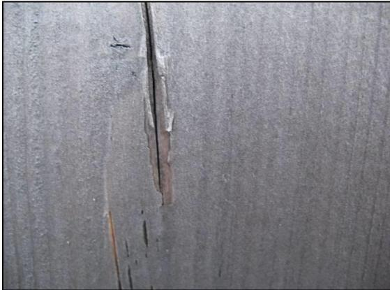
Fig. 2.2 : Fissuration et écaillage
