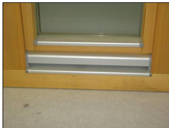
**Fig. 4.4 : Fenêtre avec protection contre les intempéries**
