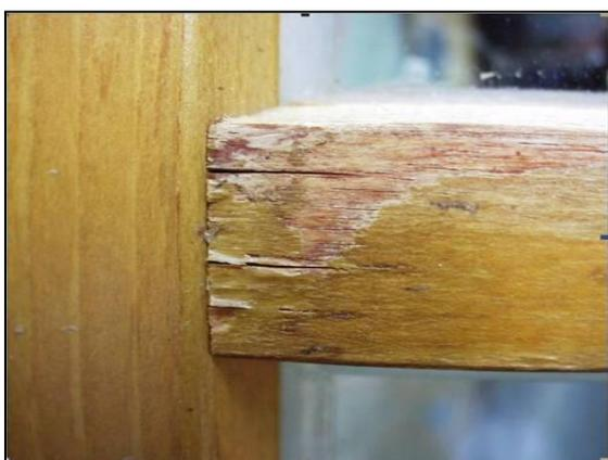
**Fig. 4.5 : Dommages dans la zone des joints**
