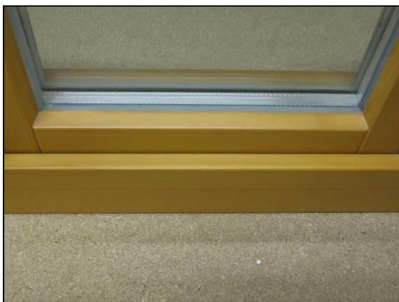
**Fig. 4.3 : Fenêtre sans protection contre les intempéries**
