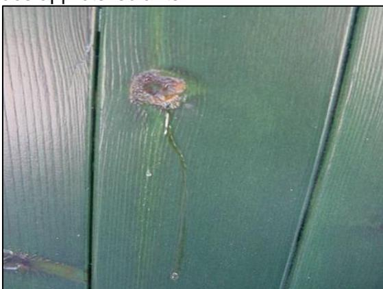
Fig. 2.4 : zone des noeuds Fuite de résine dans la zone des nœuds
